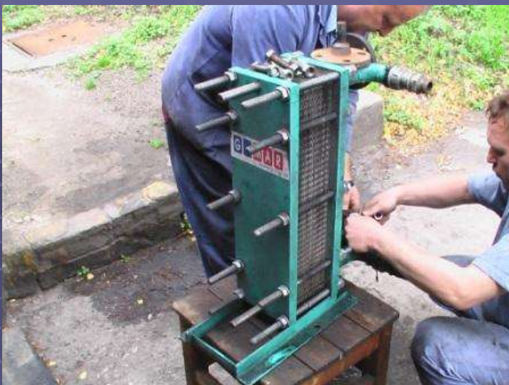
После 60 мин – окончательный демонтаж
