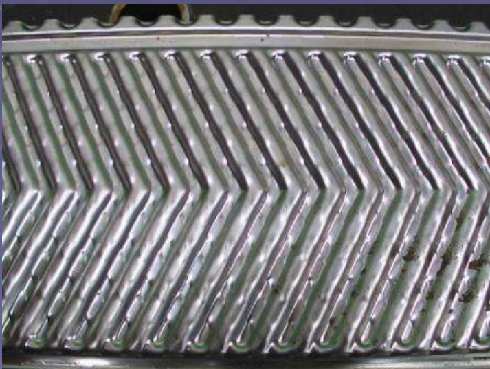
Ламели полностью очищены от отложений водного камня, ржавчины и загрязнения.
