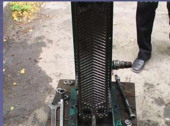
Через 20 мин очистки удалось растворить отложения только частично...
